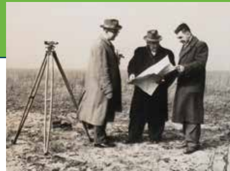
Landmeters aan het werk bij Tiel (0670-9088)
